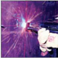
시공설계에 준하여 스테드 핀 배치를 위한 선긋기를 하고 핀을 용접한다.
