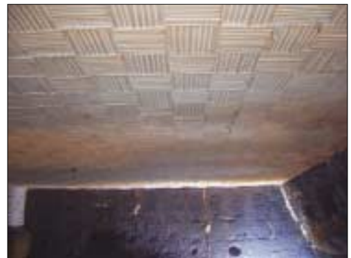
가열로 균열대 Z-Blok 시공
